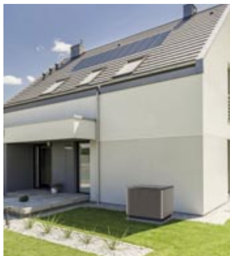
Markus Blank (Foto oben) erhält Verstärkung: Künftig gibt es die effiziente Kombination von Wärmepumpen und PV-Anlagen (Foto unten) aus einer Hand.
